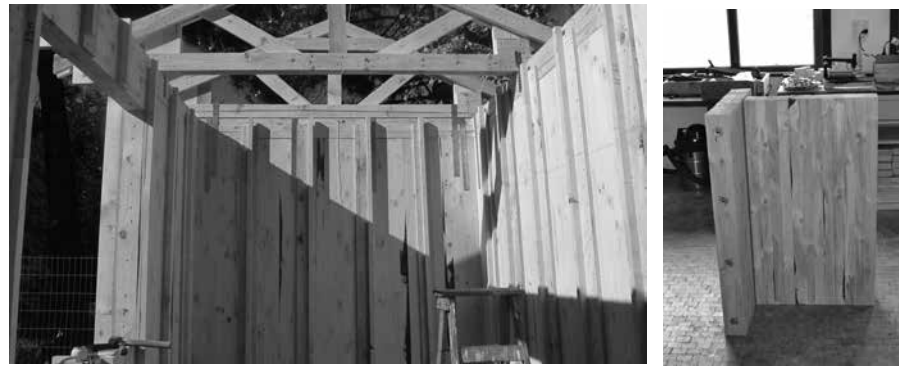
Figura 2: Ejecución de módulo de prueba.
