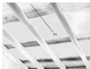
Figura 8: Puente térmico en cubiertas de madera.
