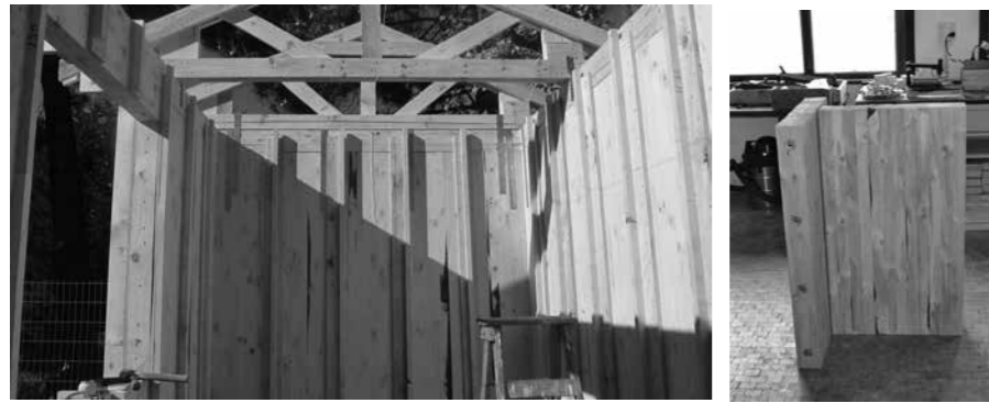
Figura 2: Ejecución de módulo de prueba.
